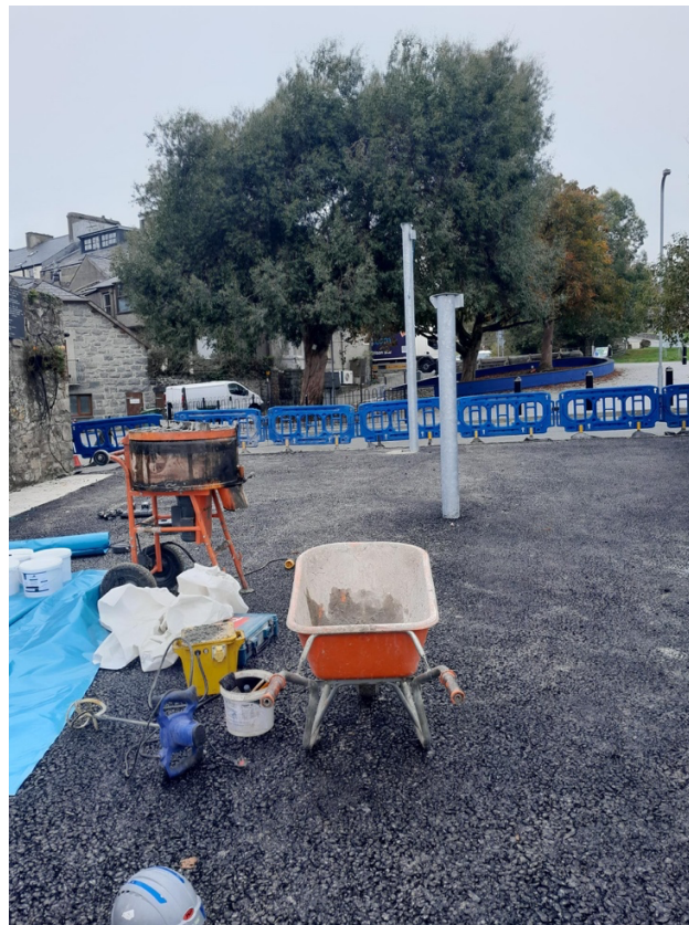
Delwedd 2: Arwyneb newydd wrthi'n cael ei gosod ar ôl tynnu'r hen arwyneb
